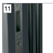
Przegroda termiczna, dwie uszczelki w ościeżnicy
